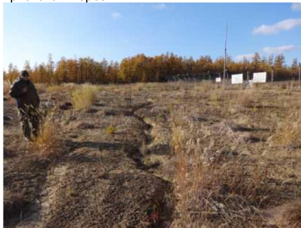
Фото 4 — участок, примыкающий к крановой задвижке, с плохим надпочвенным покровом и признаками эрозии
