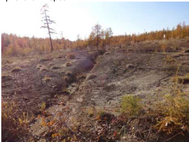
Фото 3 — участок, примыкающий к крановой задвижке, с плохим надпочвенным покровом и признаками эрозии
