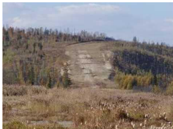
Фото 4 — вид на юг; показан склон ПЗ с раскателями и эрозией. На переднем плане присутствует флора водно-болотных угодий.
