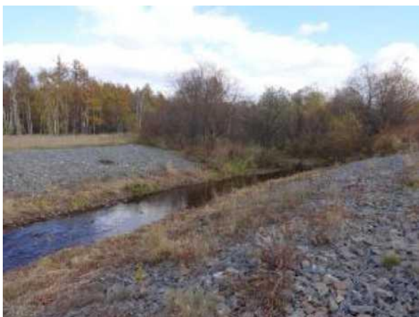
Фото 3 — вид вверх по течению; на берегах реки видны матрацы Рено
