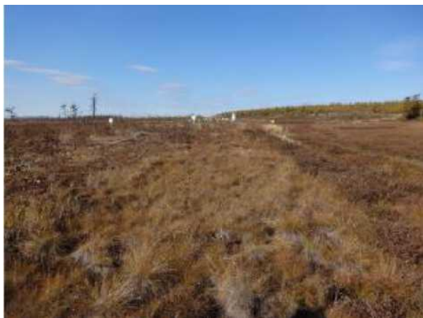
Фото 3 — пруд с осокой по краям, образовавшийся над трубопроводом
