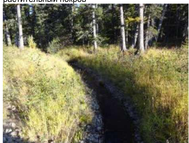
Фото 4 — вид на дренажное сооружение, защищенное каменной насыпью, и хороший растительный покров
